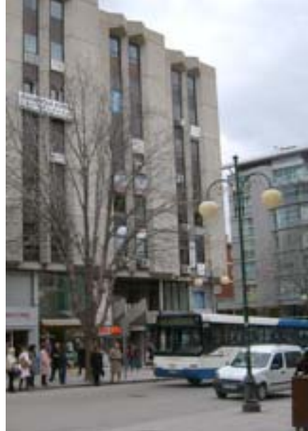
Figure 36. Gümüşsoy Pasajı Source: Author's archive
