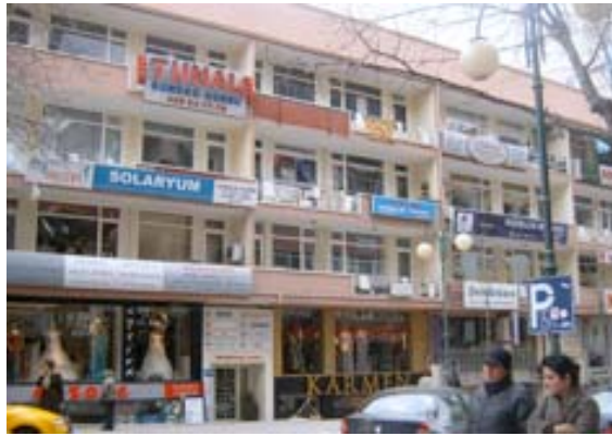
Figure 19b. Üniversite Apartmanı Source: Author's archive
