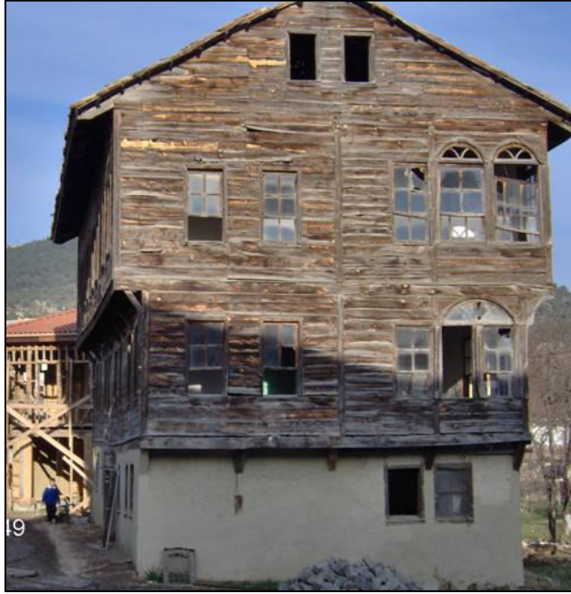
Figure 4.26. Timber cladding on Rüştüye Mektebi (author, May 2007)
