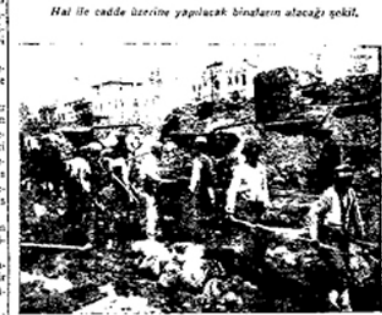
Halin inşaatı kazılarla devam ediyor.
