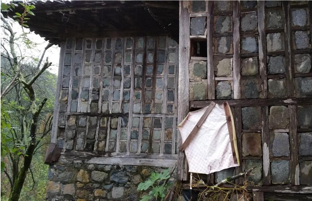
Figure 3.12. Dolma göz walls of Yolgeçen 15
