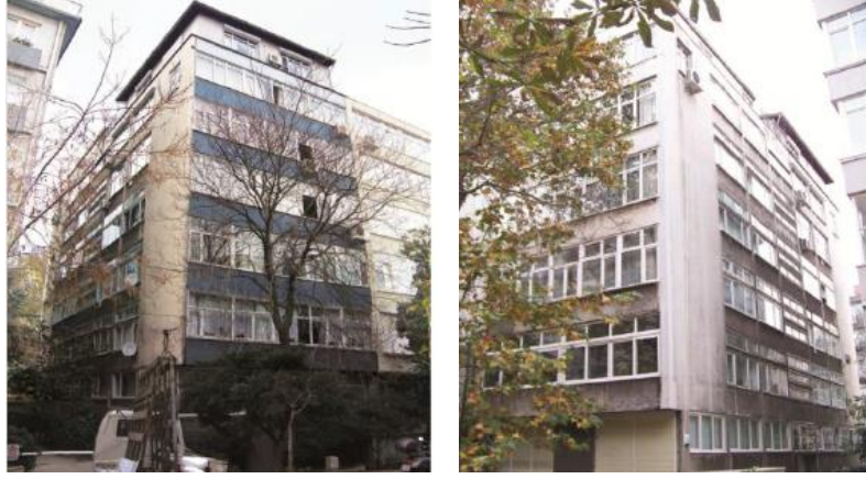
Figure 35 The front and side façade of Hatay Apartment in Teşvikiye, 2010 Source: Arbil Ötkünç, İstanbul Hatay Apartmanı, Türkiye Mimarlığında Modernizmin Açılımları VI
