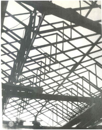
Figure 103 The steel structure of the roof, 1964 Source: Hakkı Önel, et al., Prof. Y. Mimar Ö. Maruf Önal, Meslekte 42 Yıl , 1985 Figure 104 Folded plate roof (Detail), Taksim, İstanbul, 1964 Source: Yılmaz Zenger in Maruf Önal, “Taksim’de Benzin İstasyonu”, 28
