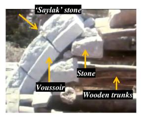
Figure 4. 14 Formwork Voussoirs<sup>10</sup>
