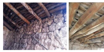
Figure 3. 52Timber beams with lata
