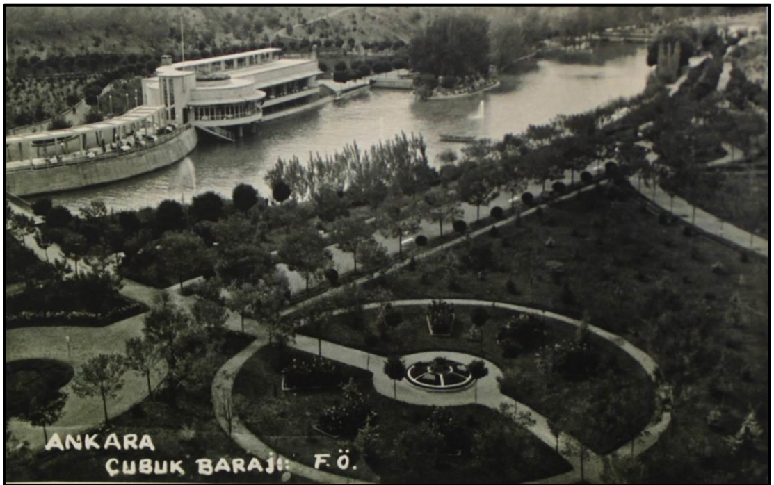
Figure 4.35 Recreation Area of Çubuk Dam in 1938. Source: Cangır, A., Cumhuriyet'in Başkenti, 2007.
