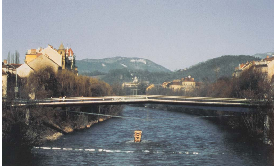
Figure 3.4 - Steg über der Mur, Austria [41]
